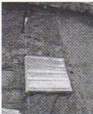
Cuando existen obstáculos (estructuras de drenaje, cajas de inspección, etc.), se deben colocar a su alrededor hilos, para lograr más precisión.
