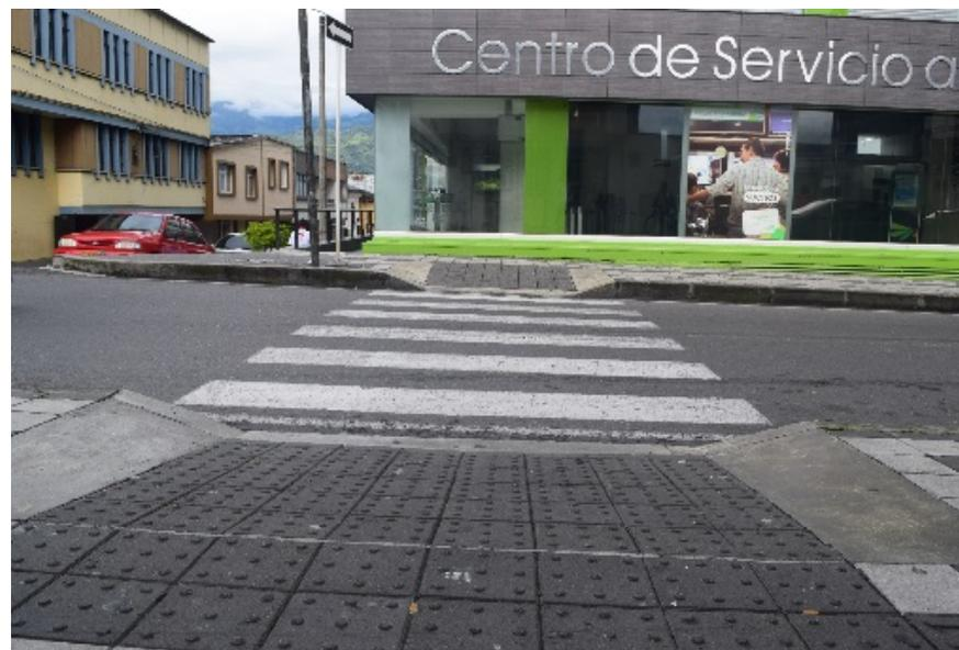
*Ilustración 6: Renovación de Andenes del Centro.*
