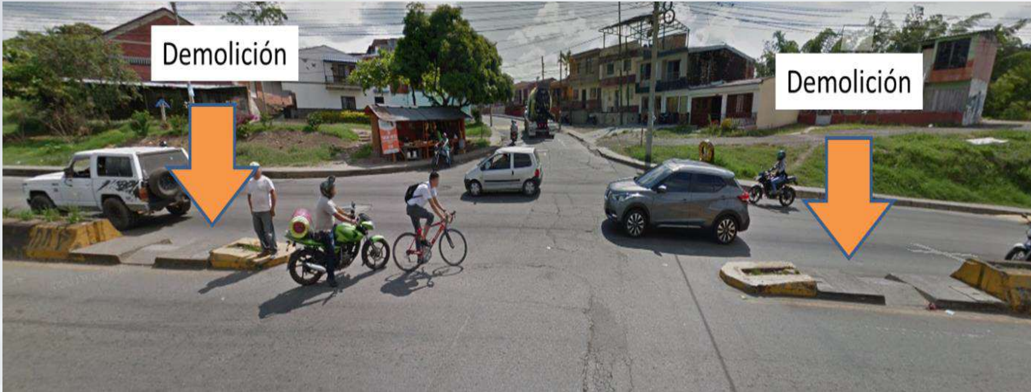
Intersección Calle 47 - “mini glorieta” con Barreras plásticas (Maletines)
